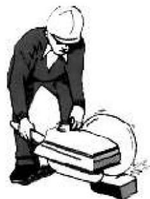
3 Remate con piezas cortadas a medida.
