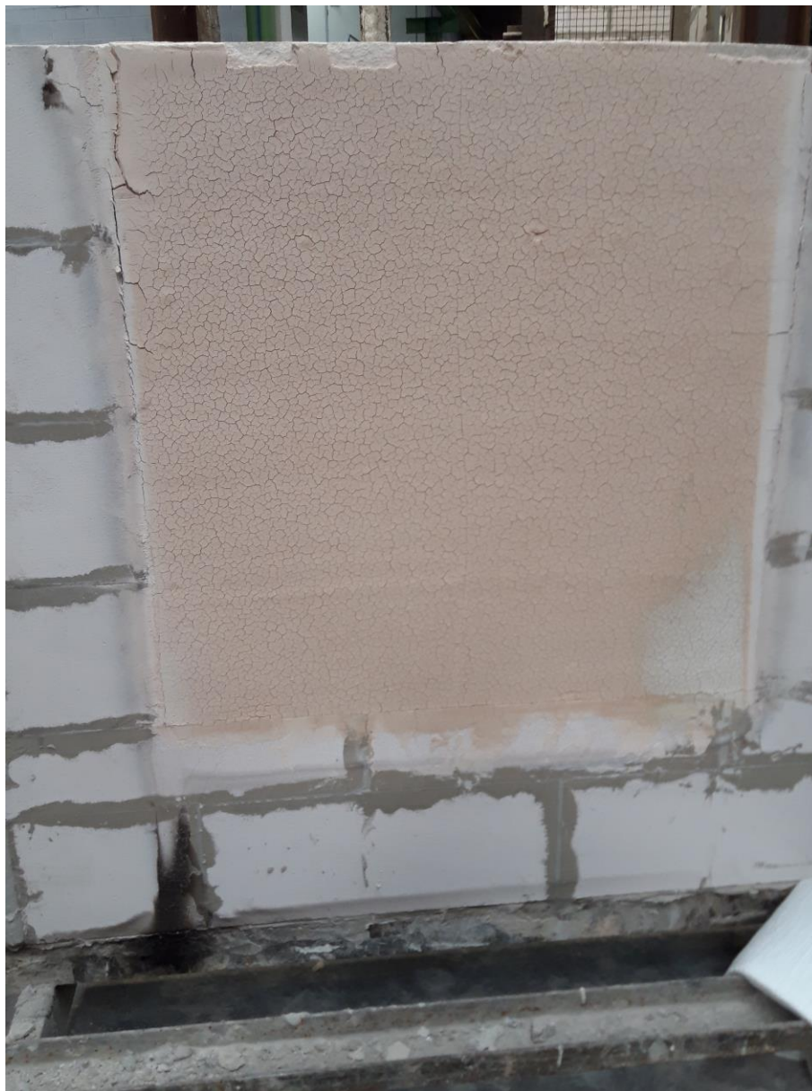
Fotografía 8: Aspecto de la muestra al finalizar el ensayo, cara expuesta.
