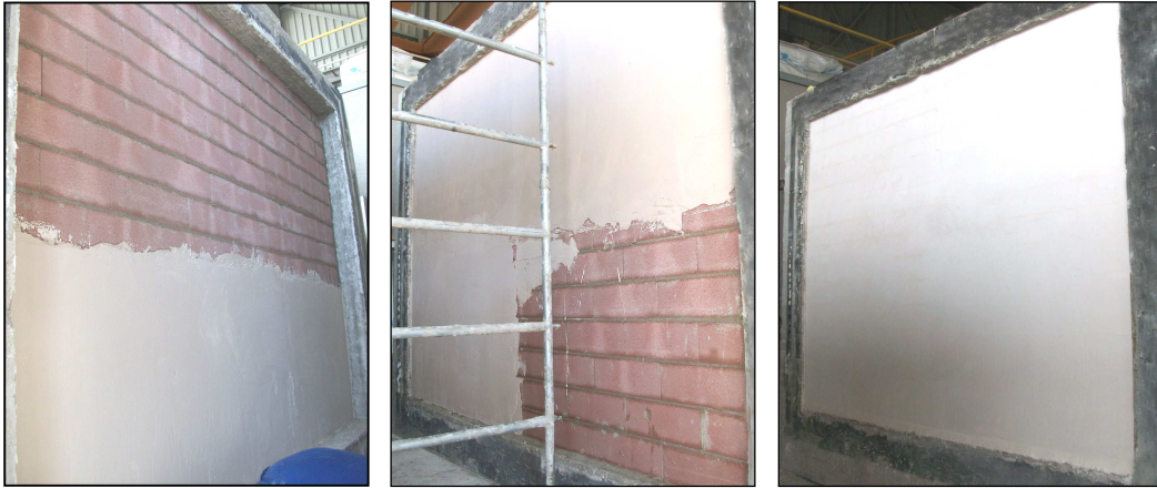
Imágenes 9, 10 y 11 Enyesado del cerramiento construido
