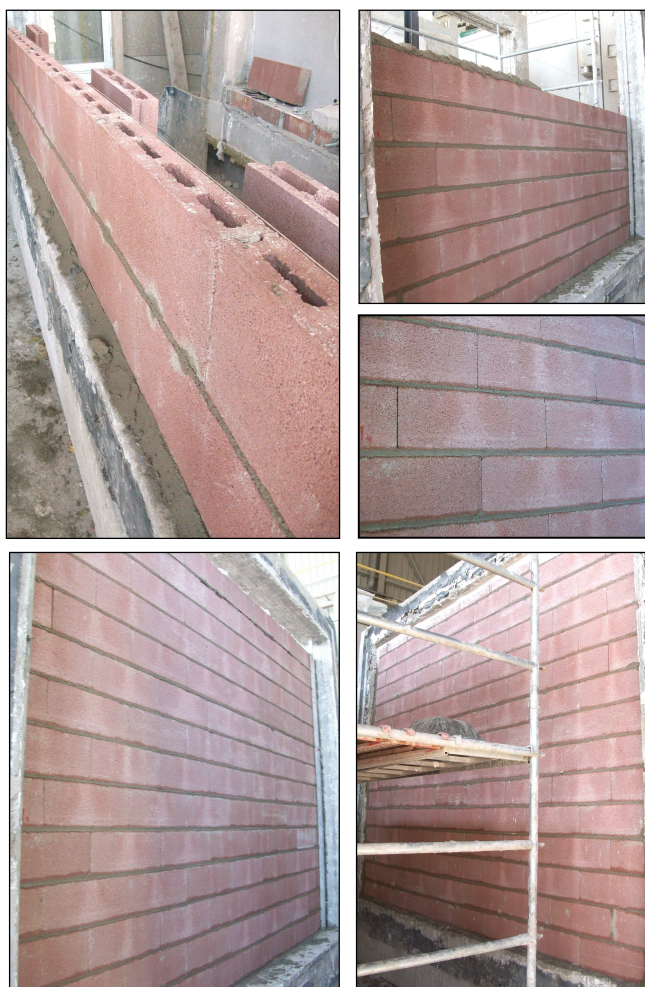
Imágenes 4, 5, 6, 7 y 8 Construcción de la pared de GEROBLOCK TABIQUE ACÚSTICO 38 dBA
