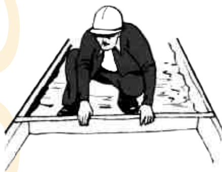
1 Nivelación de lecho de arena con espesor uniforme de 4-5 cm.
