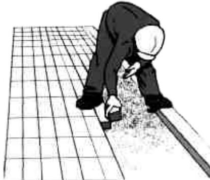
2 Colocación de adoquines sin pisar la arena de base.
